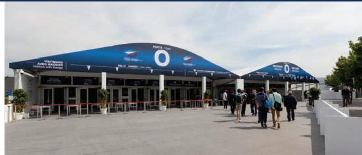
parois vitrées. La toiture est équipée de toiles blanches opaques et est liée au système de gouttières intégrées. Celui-ci permet d'évacuer l'eau de pluie et de maintenir les toiles tendues. L'Alure Globe est équipée de façon standard d'un système de plancher cassette en bois, posé sur longrines. Sur demande, il est également possible de changer les toiles de toiture opaques par des toiles transparentes.
